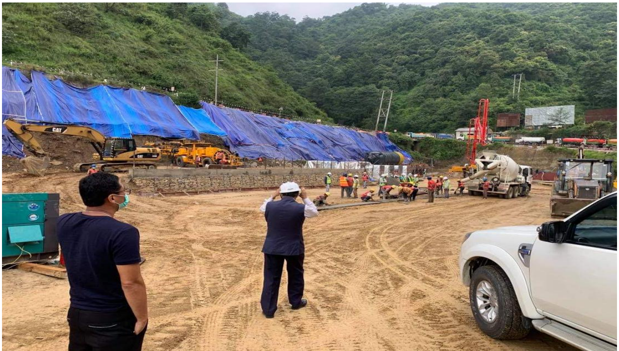
निर्माणाधीन नागढुंगा टनेल
