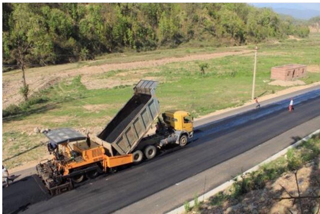
मदन भण्डारी राजमार्गको मकवानपुर जिल्लामा भएको Asphalt Pavement कार्य
